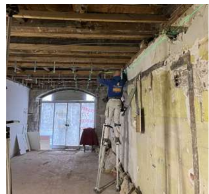
Photo pendant les travaux
