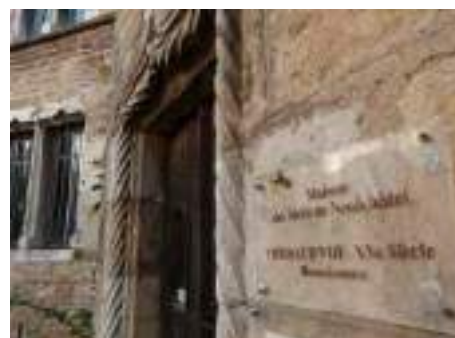
Porte d'entrée de l'Hôtel des Sires de Neufchâtel- Source Office du tourisme
