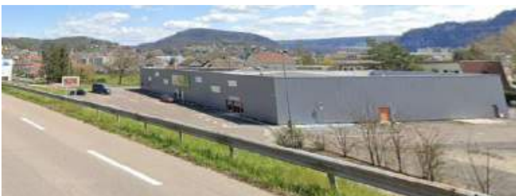
Vue sur le bâtiment commercial isolé depuis la RD683
