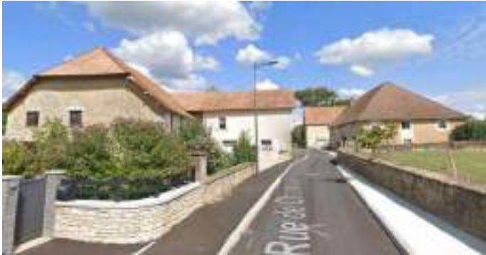
Vue vers le vieux Champvans depuis l'entrée de la ZAC Après réalisation des trottoirs
