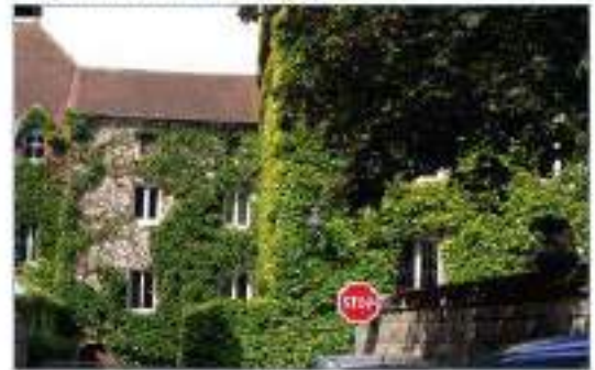
Végétalisation couvrante en façade
