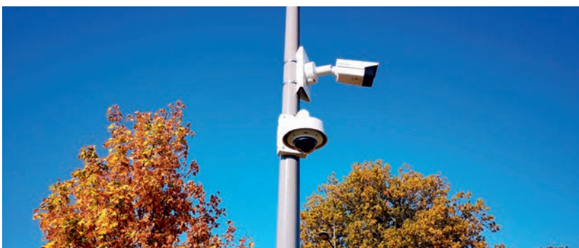
Exemple de vidéoprotection
