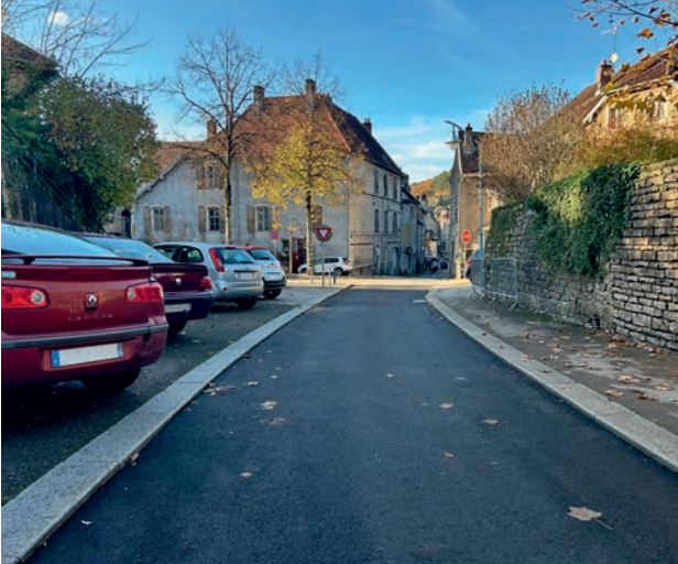
Réfection de la rue Félix Bougeot
